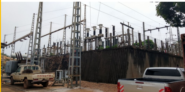
USINE DE BOALI1
