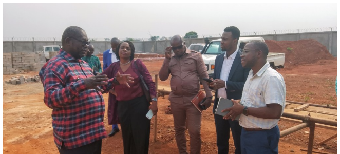
POSTE DE SAKAI EN CONSTRUCTION
